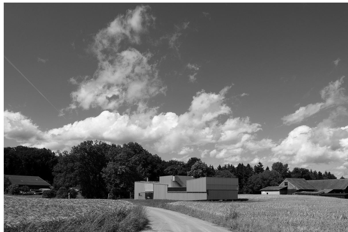
Ansicht in Richtung Norden; das Schiebedach über der Beobachtungsplattform am rechten Gebäuderand ist geschlossen
